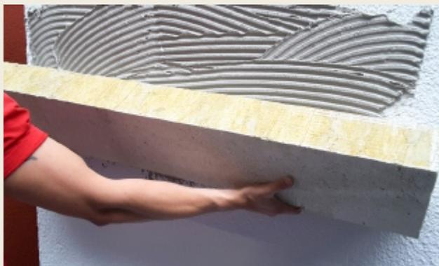
Die Dämmplatten können direkt in das frische Mörtelbett gedrückt werden oder im Wulst-Punkt-Verfahren geklebt werden.
